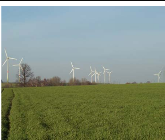
Windpark im Ortsteil Leuba
